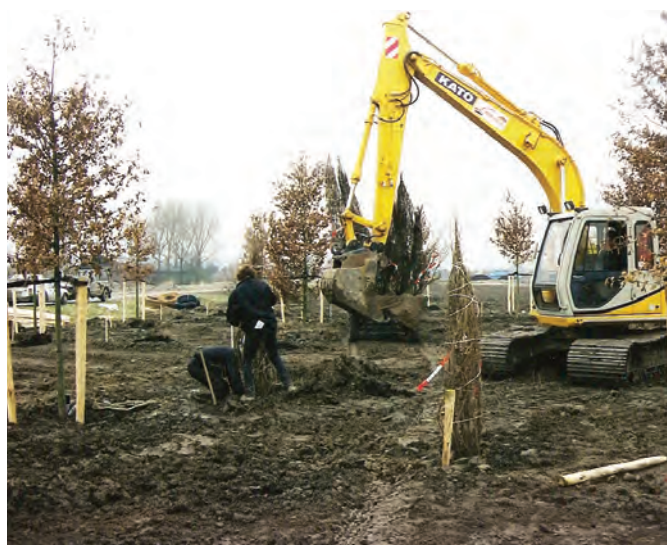
■ Afb. 6: Aanleg IBR-gedeelte in het Prins Bernhardbos (foto: Frits Ruyten, maart 1999)
